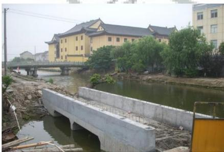
图五 进香桥消失新建涵洞桥
